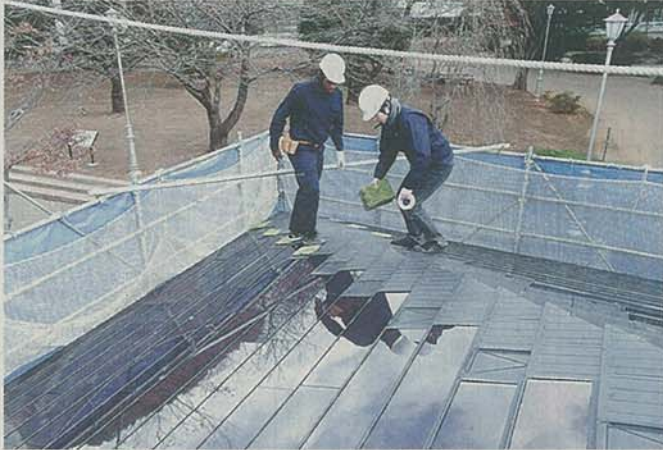
屋根材を試験施工する千葉大生＝千葉市稲毛区 の千葉大西千葉キャンパスで（新東提供）
